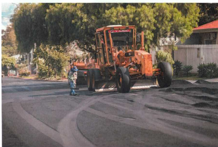
Foto 4: Execução dos serviços de repavimentação asfáltico, permanecendo a via, sem sinalização horizontal de orientação do tráfego.
